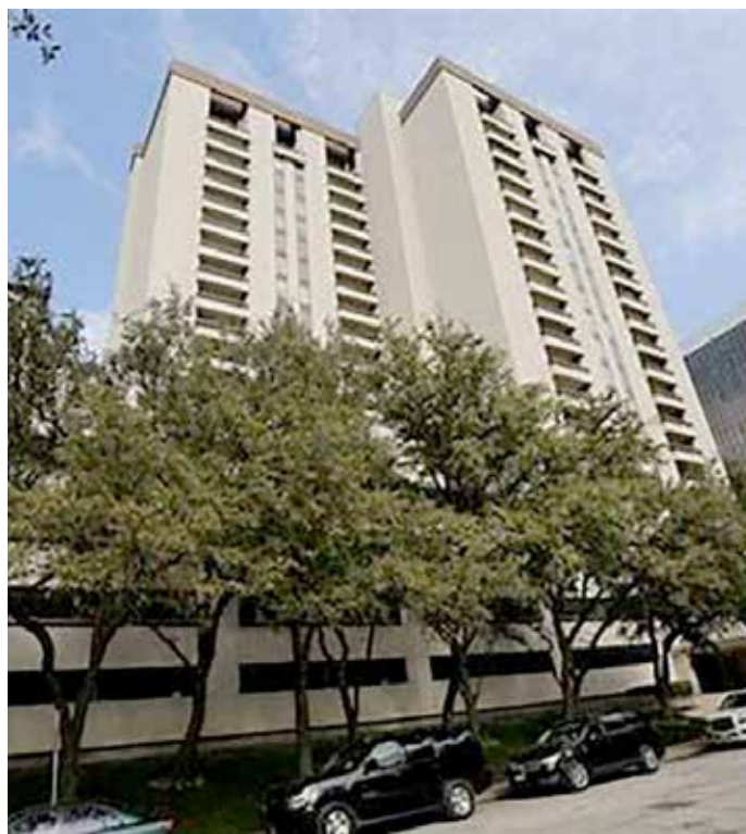
▲ 80年代に建設されたNorth Tollway沿いの 高層アパート
